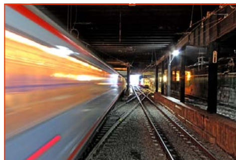
Modernización Línea "A" de Subte, CABA
