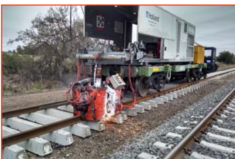
Soldadura Eléctrica en Vías FFCC Mitre, Bs. As.
