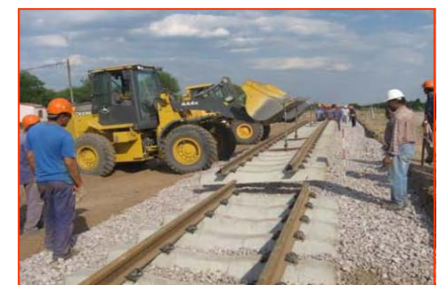
Renovación de Vías FFCC Belgrano, Chaco
