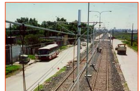
Construcción Premetro, CABA
