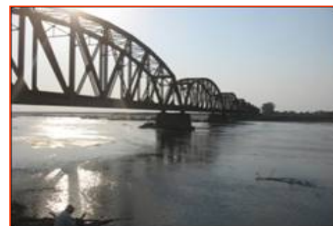
Puente Río San Francisco, FCGB
