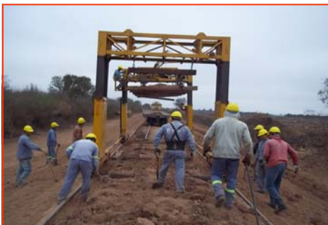
Renovación de Vías FFCC Belgrano, S. del Estero
